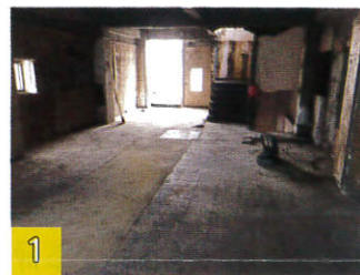
1 解体工事が完了したスケルトン状態に。
