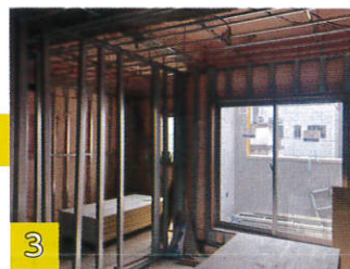
3 軽鉄による間仕切・天井の下地組立てています！
