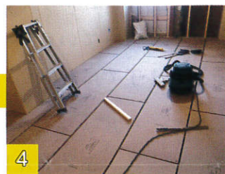
4 遮音性と配管、断熱性能を兼ねたフリーフロア下地。
