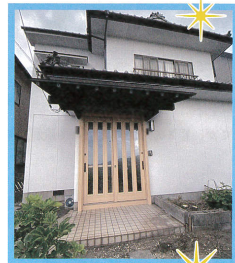
AFTER 工期約30日間(外壁塗装、玄関扉及び周辺機器交換、波板屋根交換等を含む)
